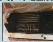
アルミフィン高圧洗浄中
